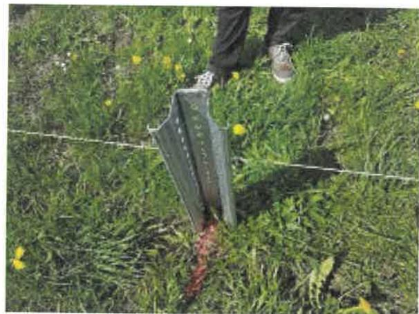
Abbildung 6: Rammfundament
