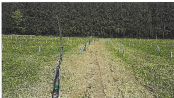
Abbildung 4: Verfüllter Kabelgraben
