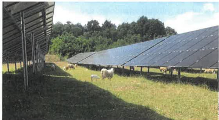
Abbildung 10: Extensive Schafbeweidung im Solarpark
