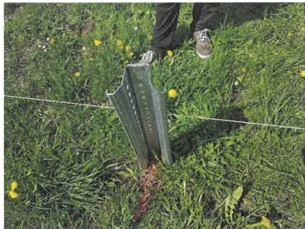
Abbildung 6: Rammfundament
