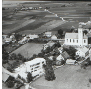
Luftbildaufnahme 1959 mit Blick auf das „neue Schulhaus“, Ausschnitt
