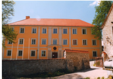
Propsteigebäude 1746/50 anstelle des früheren Meierhofes errichtet. Einst als Amtsgericht, wird es seit 1993 als Neues Rathaus genutzt. (barocker Dreiflügelbau mit Walmdach)
